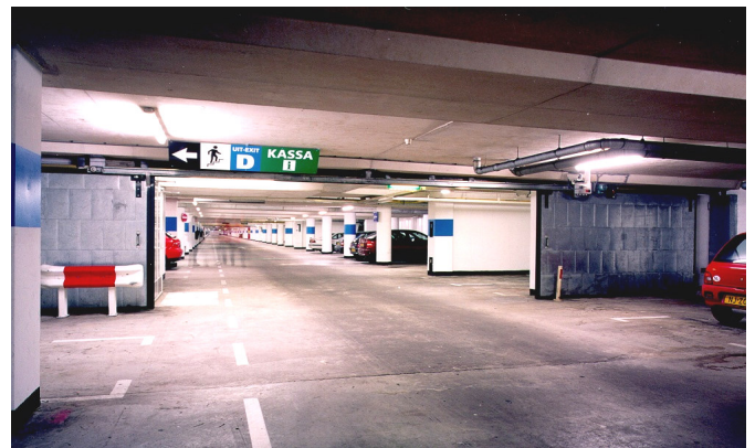
Abb. 3 Brandtore in einer Tiefgarage in Scheveningen, Holland
