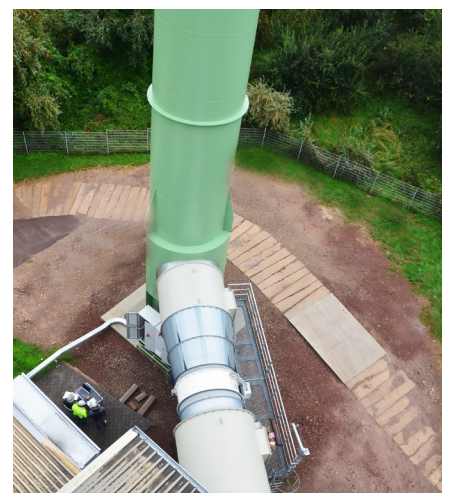
Blick von oben auf das neu eingebaute System
