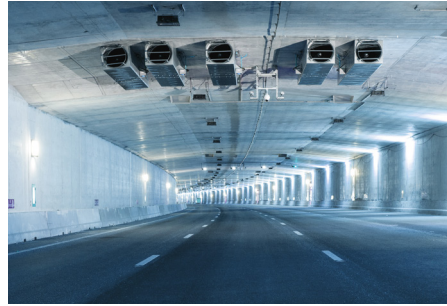
TUNNEL A2 LEIDSCHER RIJN
